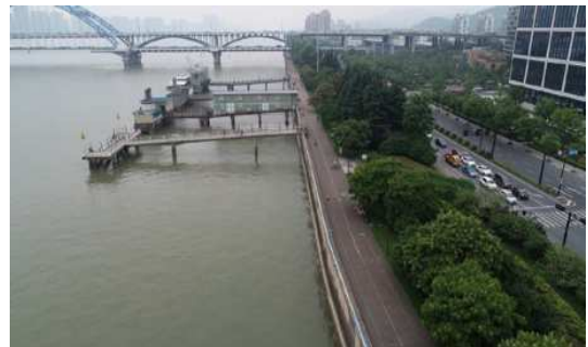
图 1.1-1 穿越段北岸大堤现场照片
