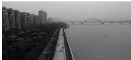
图 1.1-4 穿越段南岸大堤现场照片
