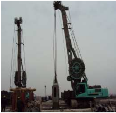
图1 抓斗成槽实拍图
