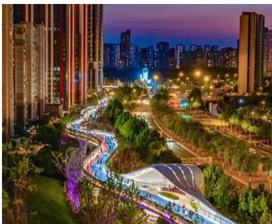
图2 南京市雨花台区建造的雨花数据线公园现场示意
