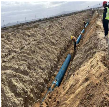
图2 软土地基中的管道安装图
